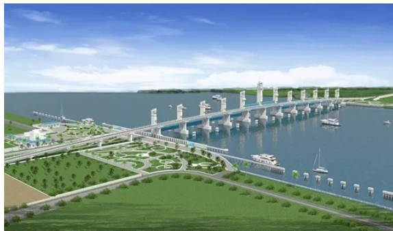
Cống Cái Lớn
